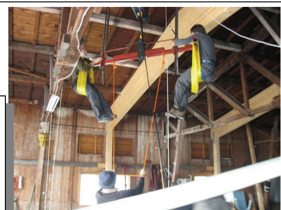
Zuerst eine Belastungsprobe, die Berechnung könnte ja fehlerhaft sein
