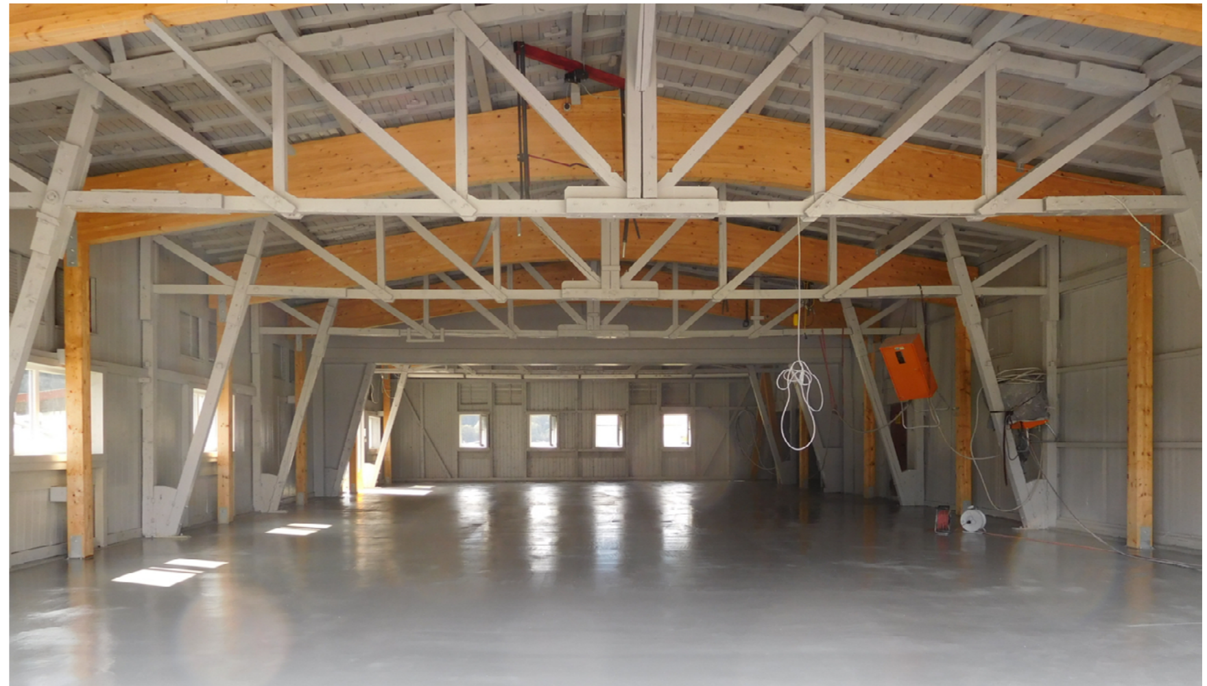
Oktober 2016: Der Rohbau der Halle ist fertig, Ein- und Ausbauten fehlen noch
