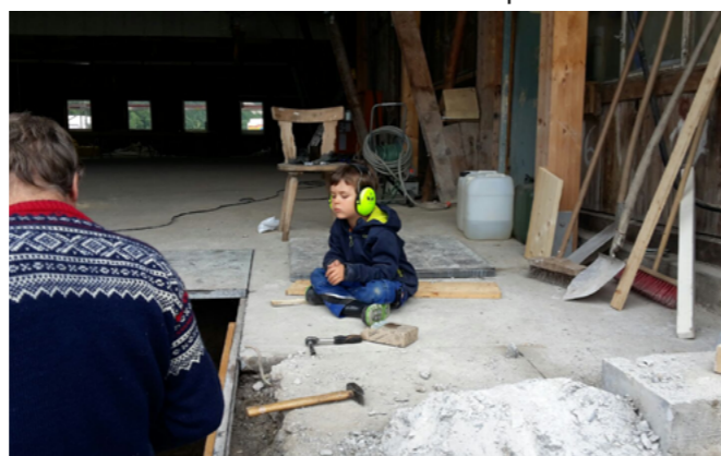
Bauleitung: Mit prüfendem Blick und warmen Ohren wird penibel überwacht
