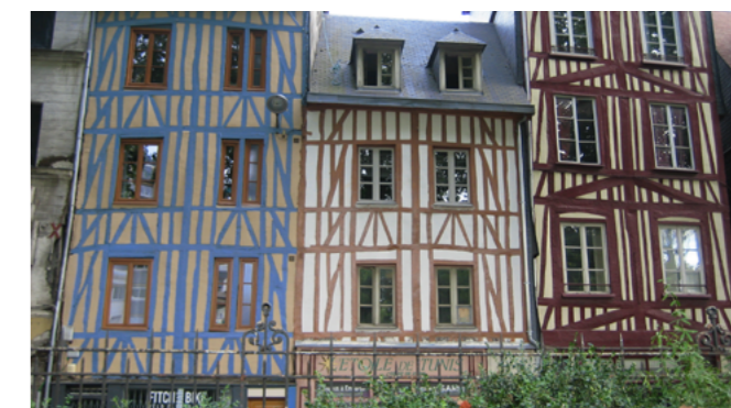
Fachwerk-Fassaden: Städtäuser in Rouen
